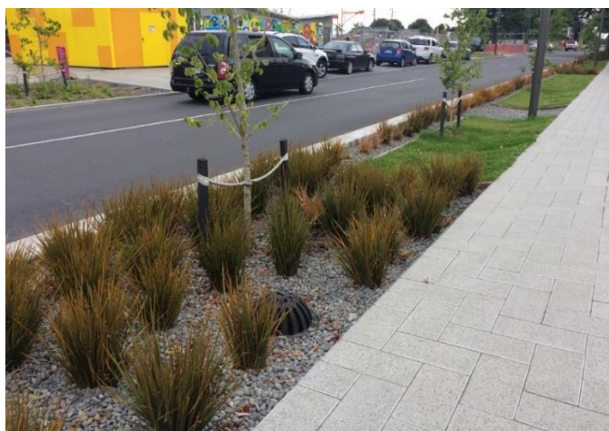
Figur 14. Exempel på makadamdike som täckts med växter och gräs.
